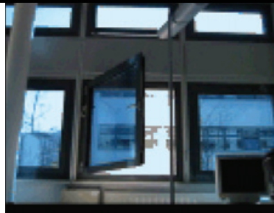
Prototipo de ventana gasocrómica. Fuente: Platzer (2003)
