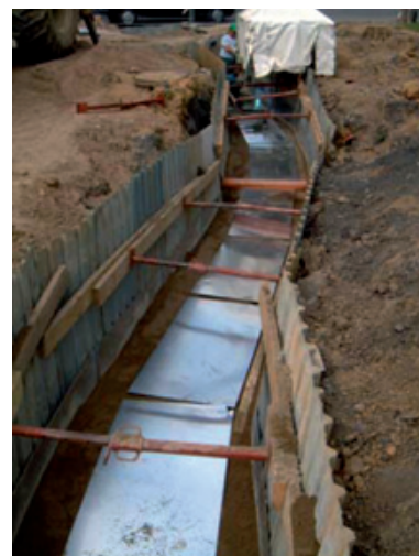
Fig. 1: Instalación de pantalla de aluminio en zanja [8]
