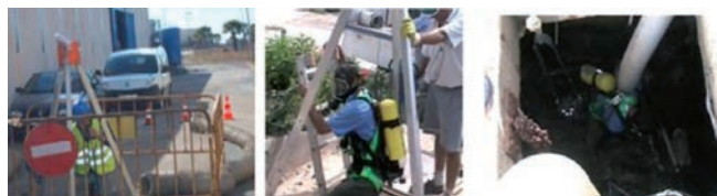
Fig. 6: Operario bajando a un espacio confinado con EPI
