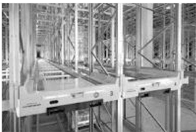
Fig. 2: Sistema de almacenamiento con disco shuttle
