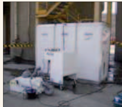
Cabina de descontaminación para personal y depresores.
