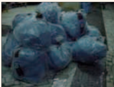
Almacenamiento de bolsas con residuos de amianto.
