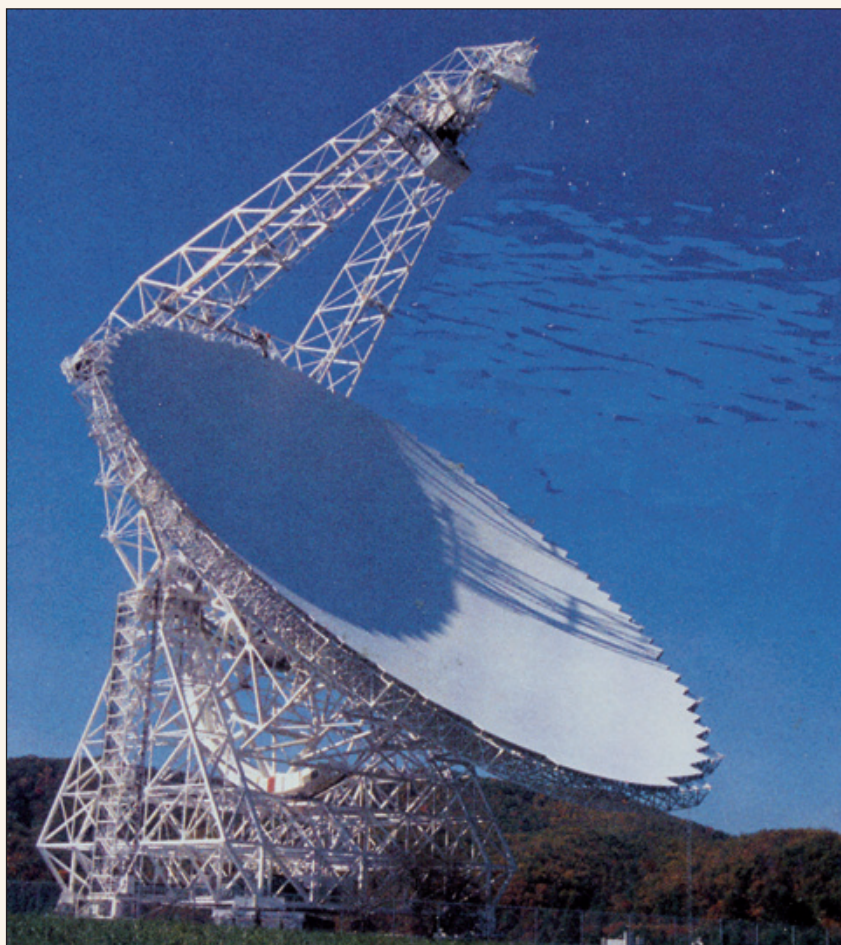
Foto 5. El paraboloide de 100 m de diámetro, de Green Bank, West Virginia, EE. UU. es el mayor del mundo totalmente orientable. Puede captar señales muy débiles, pero no tiene el poder de resolución del interferómetro de Chajnantor.
