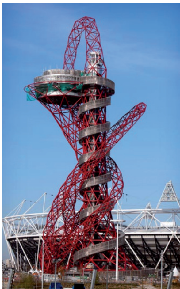
Vista general finalizándose el montaje, donde se aprecian los dos recintos visitables
