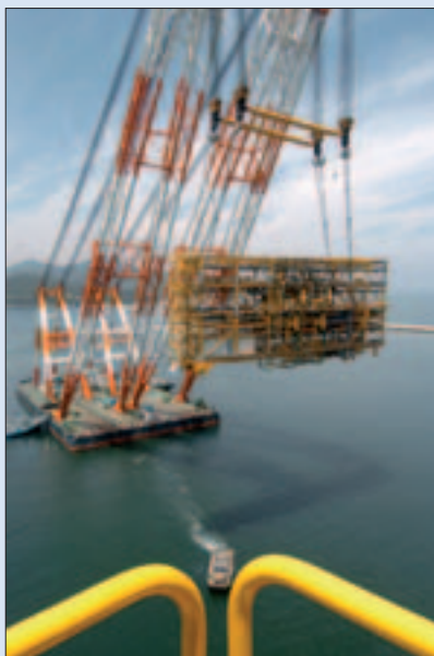
Fig. 2. Instalación de las superestructuras
