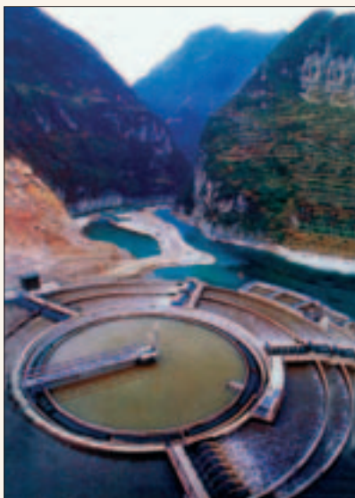
Instalación de tratamiento de agua situada en un afluente de las Tres Gargantas
