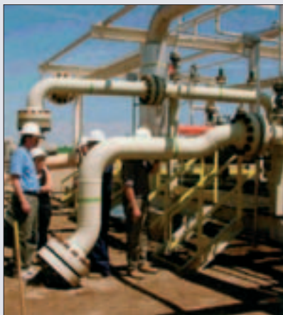
Gasoducto de CO 2 a la entrada de Weyburn
