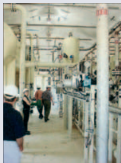
Interior de las instalaciones de Weyburn
