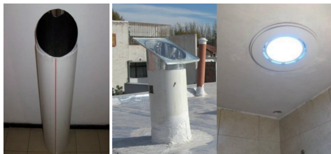
Figura 2: Prototipo 2. Izquierda, tubo conductor aluminizado; Centro, prototipo instalado; Derecha, zona de emisión de luz
