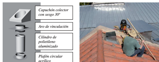
Figura 3: Prototipo 3. Izquierda, esquema del conjunto. Derecha, instalación sobre techo inclinado
