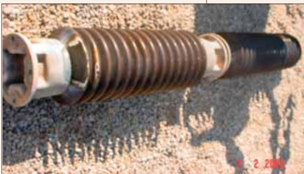
Fig. 2 - Piezas afectadas por la erosión del medio ambiente
