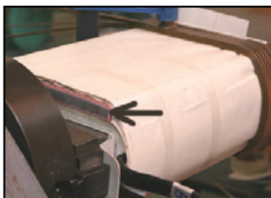
Fig. 6: Inclusión de una columna auxiliar de hierro entre primario y secundario del transformador de un convertidor auxiliar de ferrocarril de 750 V c.c. y 90 kVA + 17 kW para aumentar la inductancia dispersa entre ellos e integrar una bobina de filtro serie. Cortesía de SEPSA y Valdepinto S.L., Madrid.
