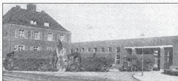
Entrada al garage municipal de Mannheim
