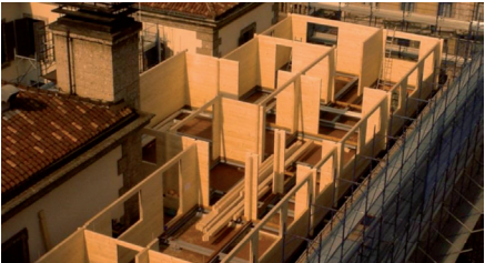
Figura 4: Ensamblaje muros de madera
