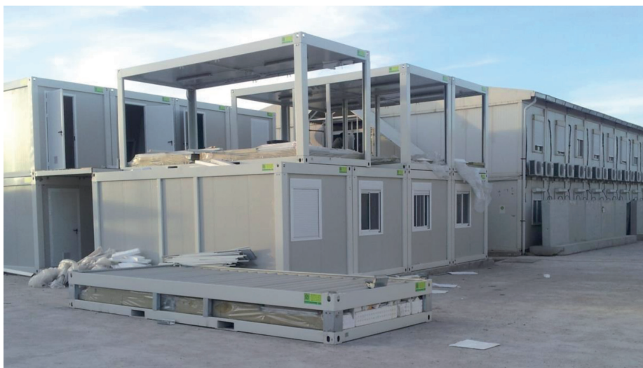
Fig. 3: Despliegue de contenedores metálicos
