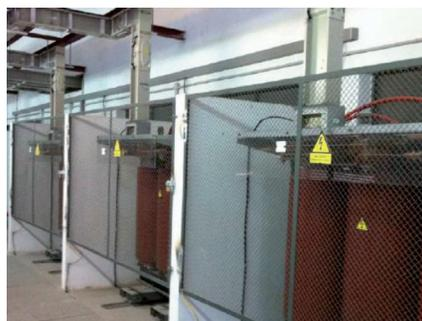
Figura 2: Detalle sistema de canalización electrificada y transformadores secos
