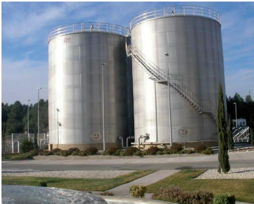
Figura 10: Detalle de depósitos de almacenamiento de aguas pluviales
