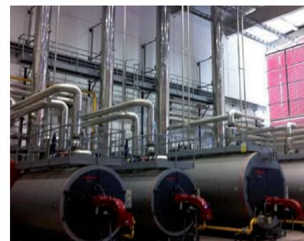
Figura 3: Detalle de sala técnica térmica de calderas, diseñada para las correctas funciones de mantenimiento
