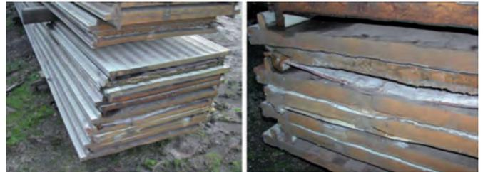
Fig. 1: Panel sándwich de caras metálicas envejecido tras muchos años instalado en una cubierta
