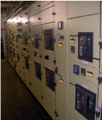
Figura 5: Detalle de sistemas de control y seguimiento en cuadros generales
