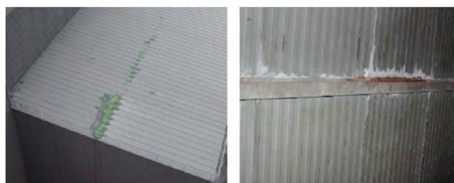
Fig. 3: Cubierta de nave con juntas rellenas de vegetación y vista del interior del deterioro causado en el apoyo sobre la correa
