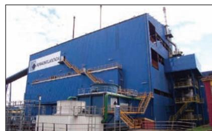
el Grupo y en ella se obtienen tres tipos de ferroaleaciones: ferromanganeso, silicomanganeso y ferromanganeso afinado. Estas ferroaleaciones se producen mediante la reducción de los óxidos de mineral de manganeso en hornos eléctricos de arco-resistencia y a temperaturas elevadas que se consiguen por medio de la energía eléctrica que se aporta.
