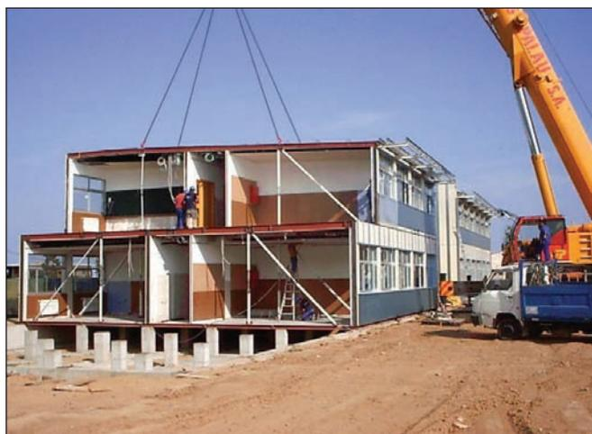
Fig. 5 Módulos tridimensionales en base acero
