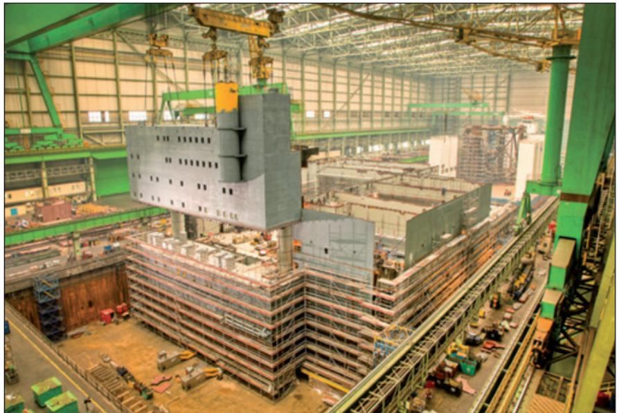
Plataforma para los equipos de recepción y transformación de energía, en construcción para SIEMENS en un astillero de Rostock
