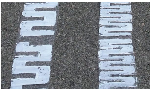
Figura 2: Bandas pintadas manualmente según prototipos seleccionados
