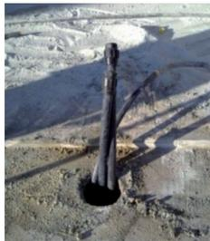
Fig.1: Extremos de la tubería en U introducida en la sonda
