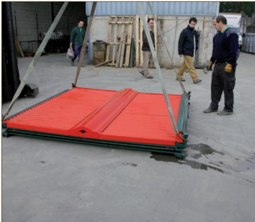
Comienzo del despliegue. La estructura puede desplegarse por diversos medios mecánicos, carretillas elevadoras, grúas, incluso puede montarse manualmente como los sistemas actuales.
