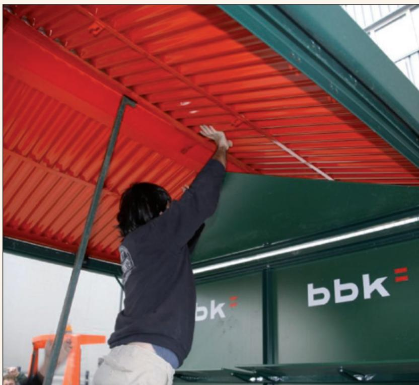
Una vez asegurada la integridad estructural, se procede al despliegue del tejado a dos aguas
