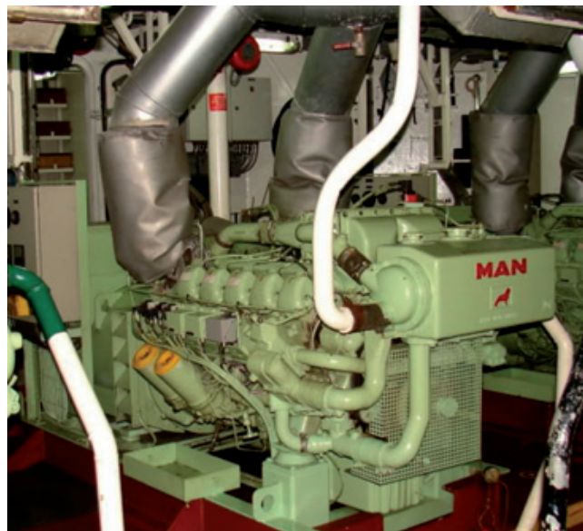
Figura 1: Motor MAN D2840LE estudiado en el presente trabajo
