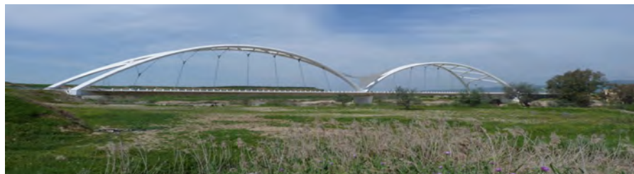
Fig. 5: Puente de Abbas Ibn Firnas (ronda de acceso al aeropuerto de Córdoba) diseñado por el ingeniero y catedrático de estructuras D. José Luis Manzanares Japón
