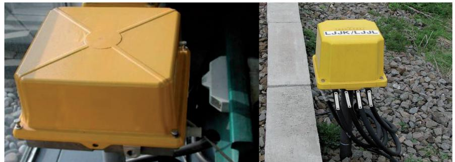
Fig. 8: Cajas de vía de unidades electrónicas funcionales (izquierda Siemens ZP43E, derecha Thales 6315 Fieldtrack)
