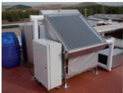
Dispositivo solar capaz de producir calor y frío.
