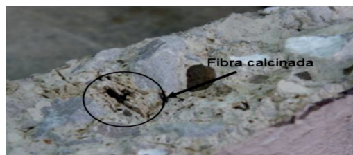
Fig. 7: Losa después de ser ensayada y expuesta a 600 °C
