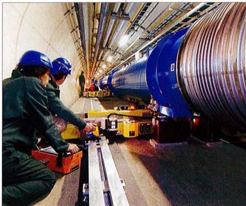
Figura 14: Instalación y alineación de los imanes dipolos superconductores en el túnel del LHC
