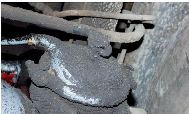
Figura 13: Toma de presión deteriorada
