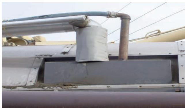
Fig. 4: Alimentador de fibras para la adición de zeolita [3]
