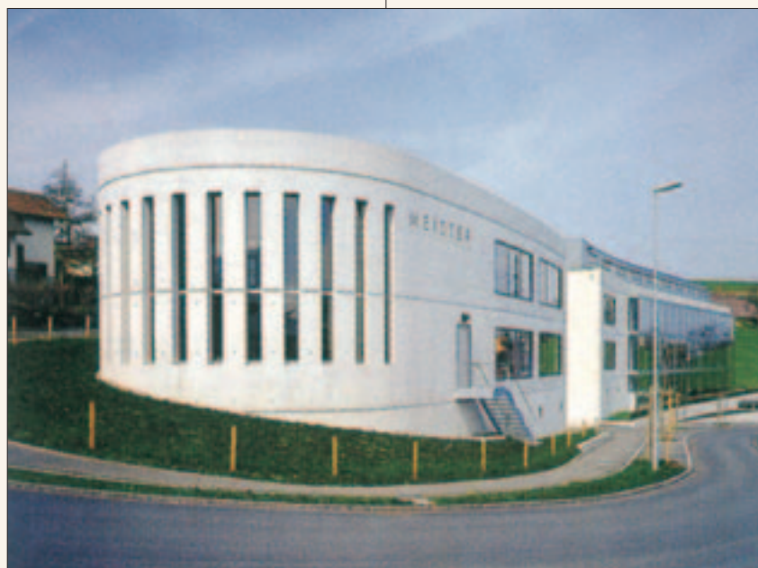
Fig. 7. Oficinas en Wollerau (Suiza) acondicionadas por un campo de 32 sondas geotérmicas.
