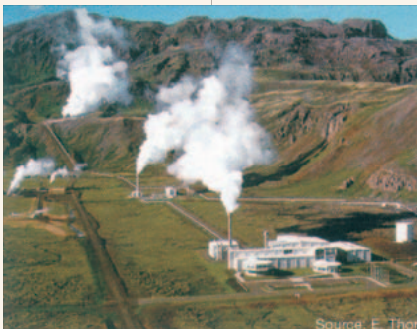
Fig. 4. Cogeneración en la central geotérmica de Nesjavellir (Islandia): 60 MWe para la red nacional y 150 MW de calor distribuidos por una conducción de 27 km hasta Reykiavik
