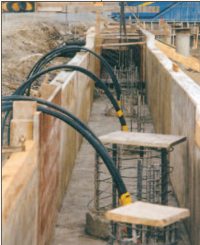
Fig. 8. Sistema de pilares energéticos para calefacción y enfriamiento en el centro escolar de Fully, Velais
