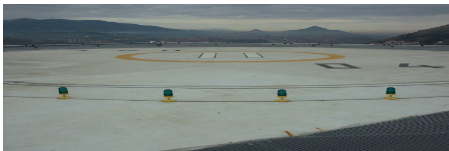
Detalle de balizamiento del helipuerto. Imagen propiedad de Torre Iberdrola AIE
