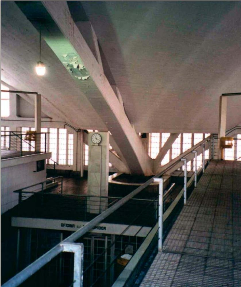
*Arranque del arco funicular en el punto B, en el cual se concentran los empujes más importantes de la cubierta*
