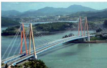
El puente Jindo de Corea del Sur, conecta la parte continental a la isla de Jindo. Una red de sensores inalámbricos, colocada en el puente realiza un seguimiento continuo de la salud estructural del puente. Es el primer sistema de vigilancia de su tipo en un puente atractivo y el más grande de su tipo para la infraestructura civil hasta la fecha
