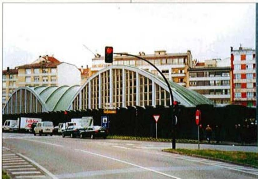
*Fachada principal, de 100 metros de longitud, en la que se puede apreciar la forma de la cubierta*
