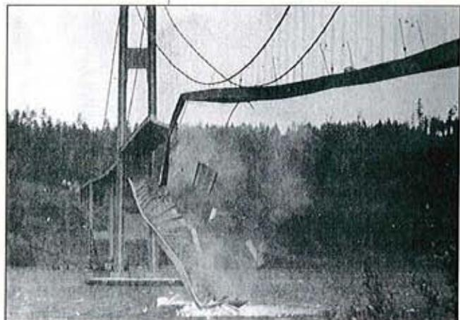
Figura 1: Colapso del puente Tacoma Narrows
