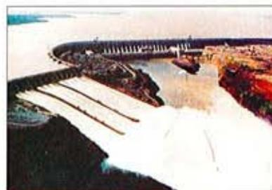
y trabajan con un caudal nominal de 690 m³/s. Su potencia nominal unitaria es de 715 MW y funcionan bajo un salto de 112,9 m y sus velocidades son de 90,9 / 92,3 rpm respectivamente.
