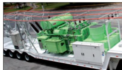
Fig. 7: Subestación móvil de 138-kV llena de éster natural alto oleico
