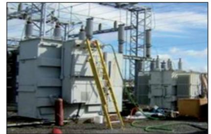
Fig. 5: Transformador de 69-kV preparándose para el rellenado en campo con éster natural alto oleico.
