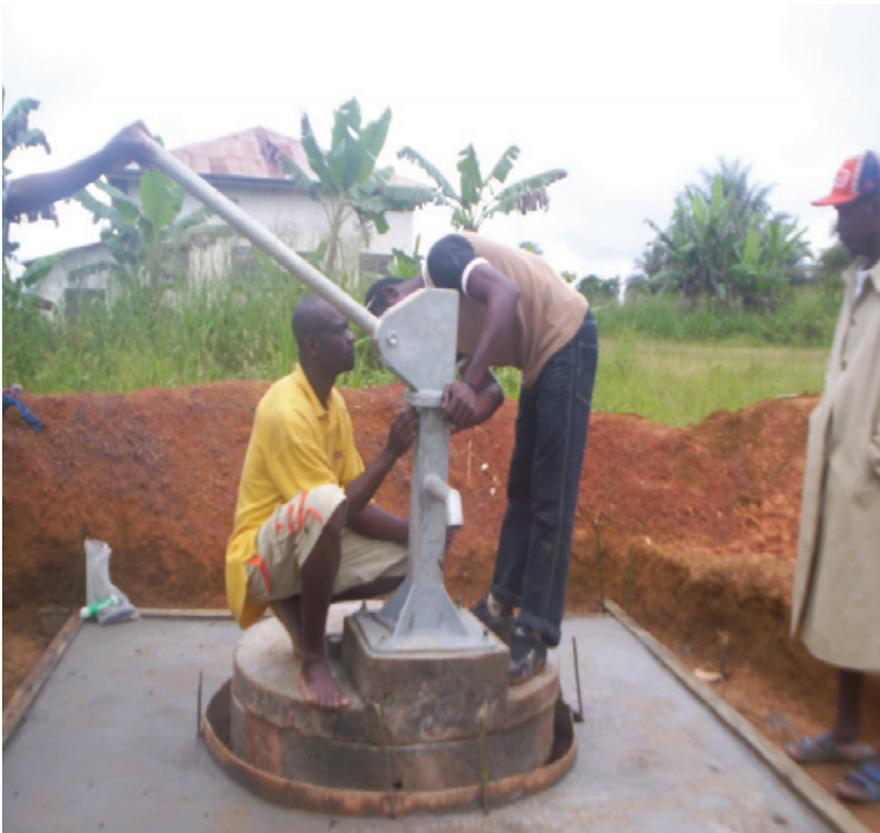
palanca y biela (que se prolonga mediante un vástago hasta alcanzar el pistón).
