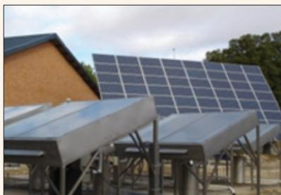
Figura 6. Vista de los frigoríficos solares y el seguidor solar fotovoltaico
