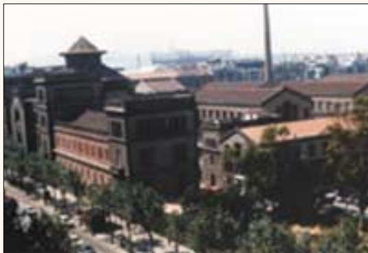
Fábrica "Can Batlló", donde se ubicó la Escuela de Ingenieros Industriales de Barcelona de 1927 a 1964
