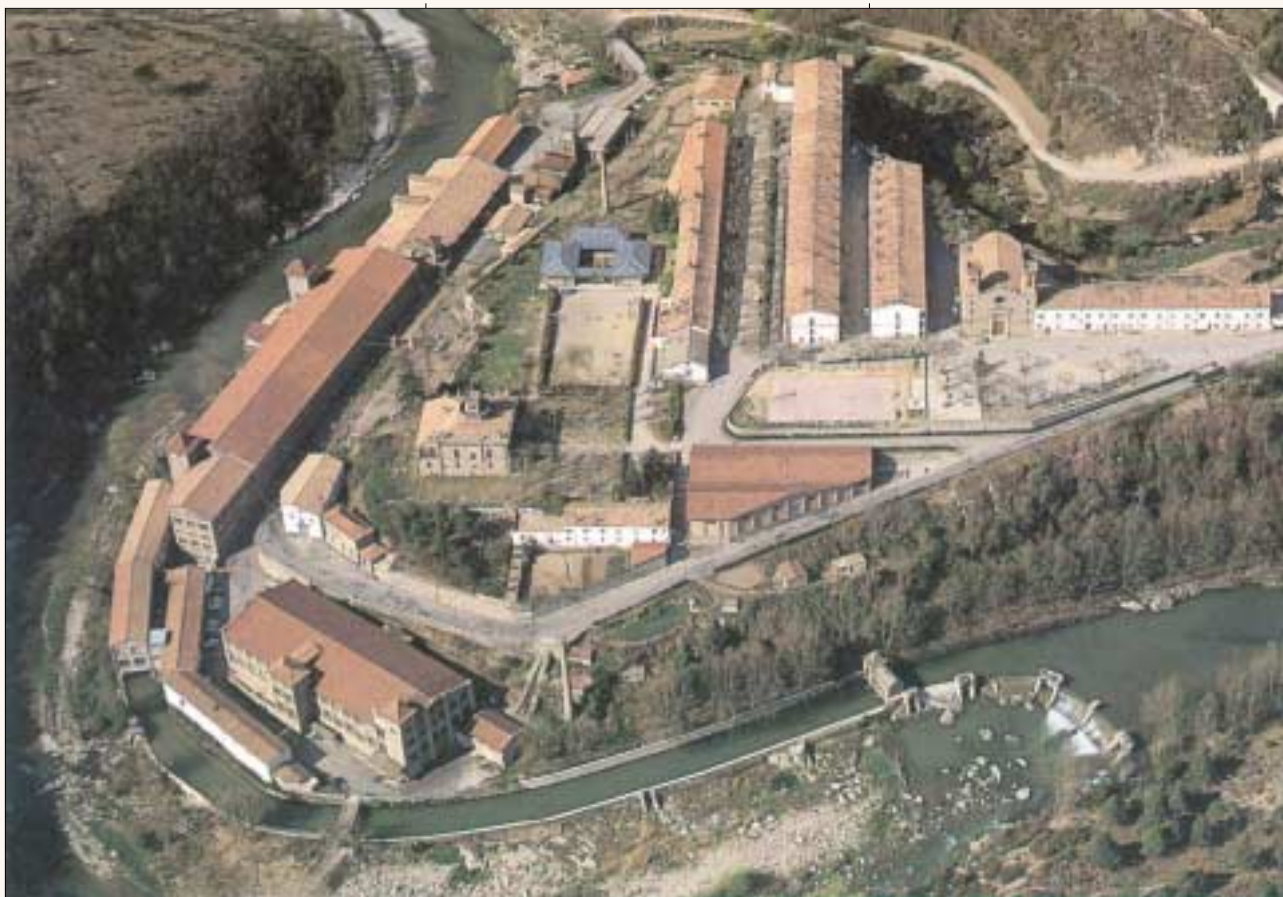
Colonia Viladomiu en Gironella, ejemplo de típica colonia industrial catalana, desplegada aprovechando la energía del río Llobregat
