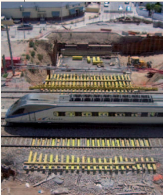
vez sustituidas todas las traviesas de una vía (la más próxima al cajón), se procede a la colocación de los paquetes de carriles de 54 kg/m, uniendo mediante cupones tres carriles atados al hilo interior y cinco carriles al hilo exterior, distanciando el solape de carriles en 5 m puesto que van a funcionar como vigas.
