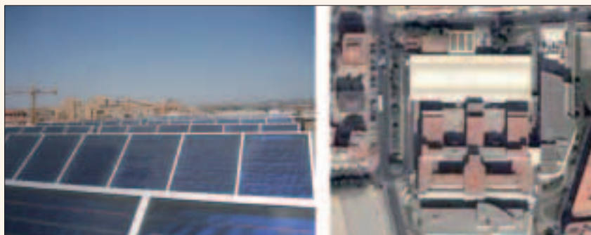
Figura 2. Ubicación de la instalación solar térmica y foto aérea del hospital
