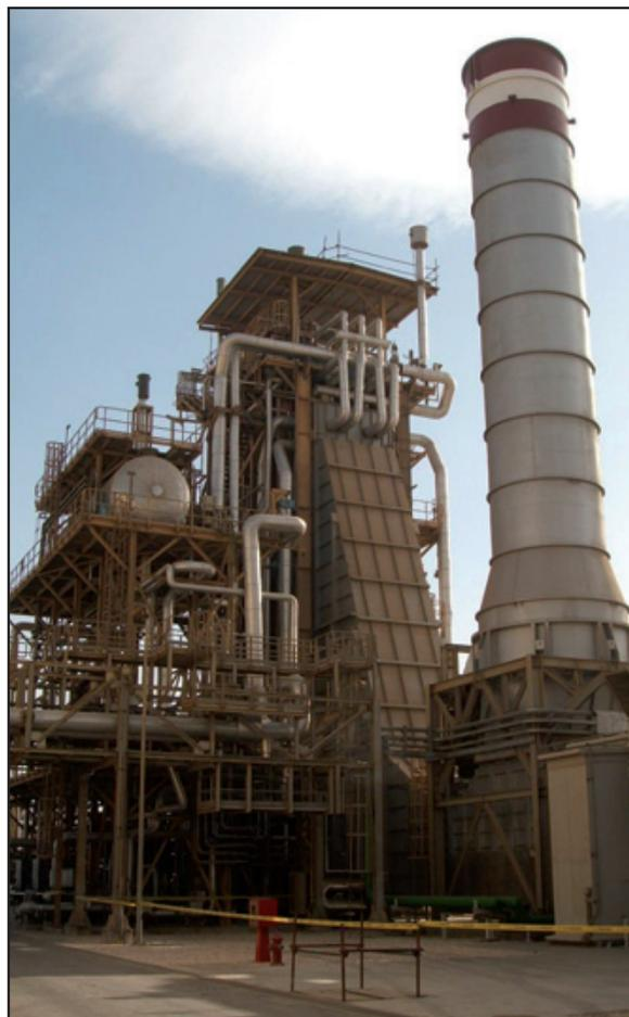
de un CC convencional, es decir, un rendimiento bruto de 50,5 % para un CC convencional llega en el caso de ISCC *Kuraymat* hasta el 62,4 % en condiciones nominales de radiación solar (50 MJ/s).
