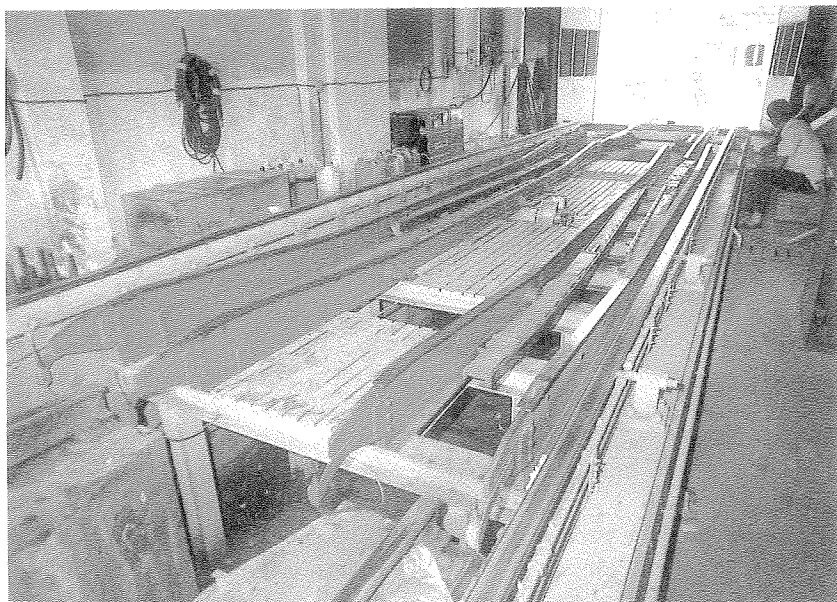
La instalación de cambio de ancho de Portbou. A medida que la composición avanza, tanto en un sentido como en otro, las guías verdes desplazan las ruedas; los carriles rojos dejan primero libres los soportes y después del cambio vuelven a inmovilizarlos en la nueva posición
