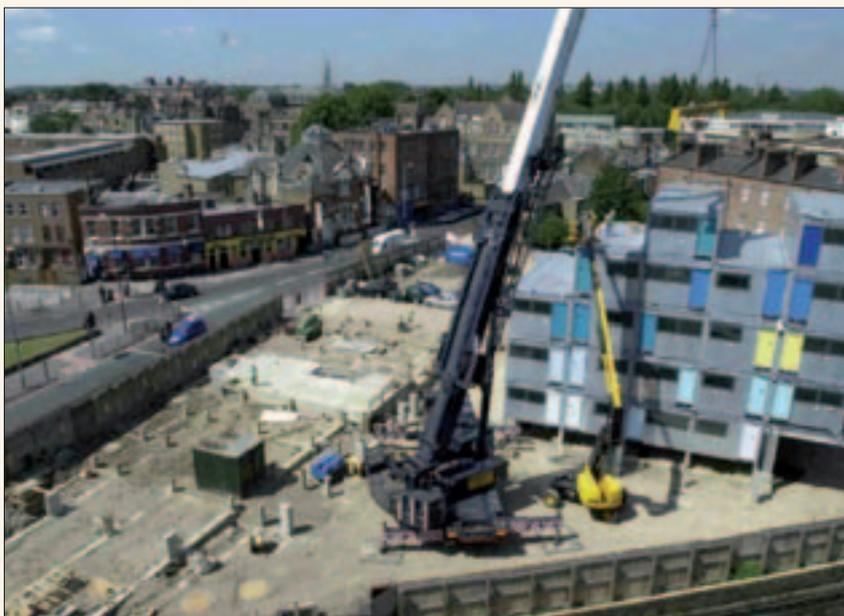
Figura 3. Proceso de montaje de módulos (Fuente: Yorkon)
