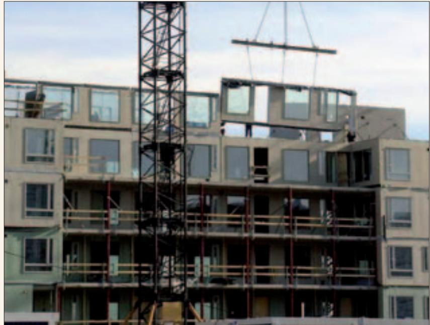
Figura 5. Instalación de los paneles portantes (Fuente: Ruukki - Proyecto STEEL)
