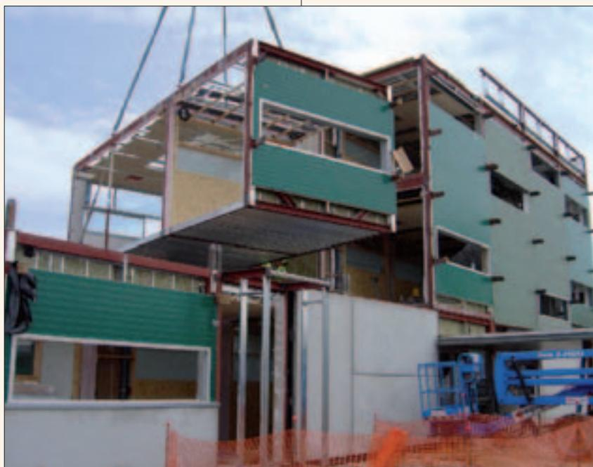
Figura 7. Instalación de las unidades modulares (Fuente: Modultec / Nogue, Ozain y Roig Arquitectos)
