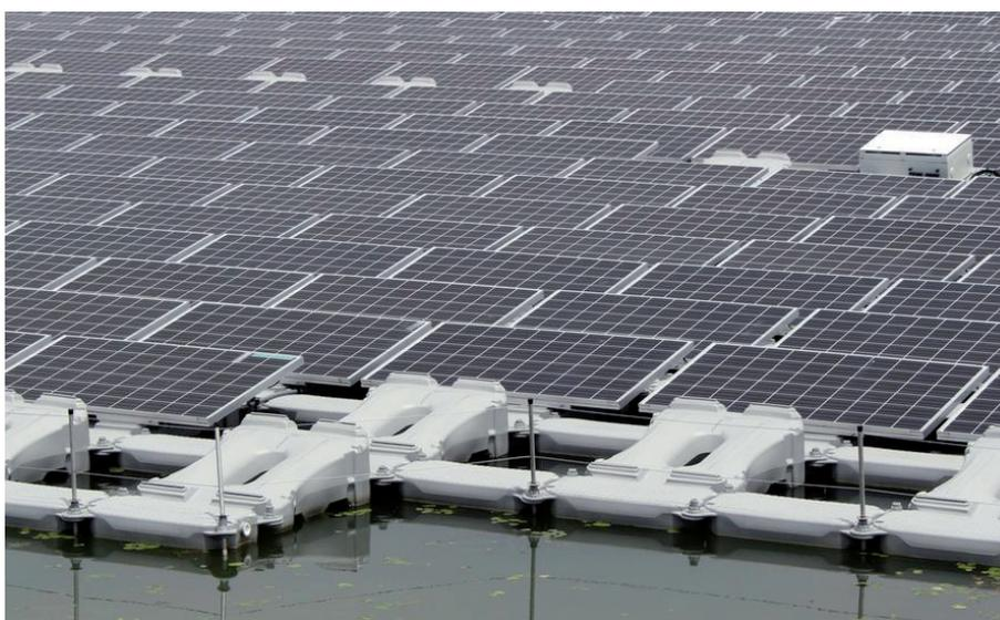
Vista del campo solar con los paneles sobre flotadores
