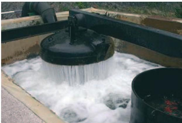
Arqueta de rotura de carga en la entrada de la Estación de tratamiento de agua potable de Barrendiola
