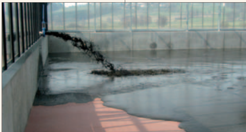
Figura 2. Entrada de fango decantado en nave-invernadero con suelo filtrante.
