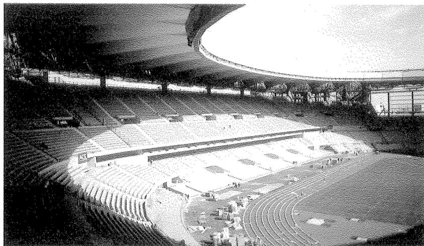
tructivo se han dejado una serie de juntas en los forjados para disipar los efectos de las deformaciones de retracción sobre la estructura. Además, se han realizado modelos específicos para los nudos de los pórticos y elementos singulares.
